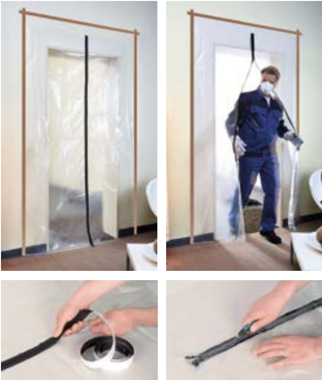
Instalación de la cremallera.
