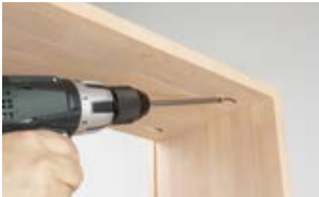
Fijación mediante tirafondo
