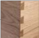
Cajón con acabado tipo Cola de Milano
